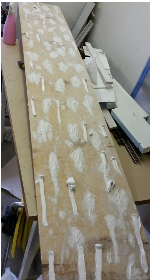
Kuva 24 Akryylimassan levitys
