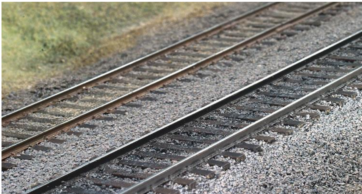
Kuva 17 Sorastettua ja maalattua rataa
